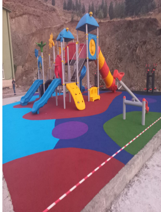
SÜMBÜL MAHALLESİ PARK YAPIM İŞİ
