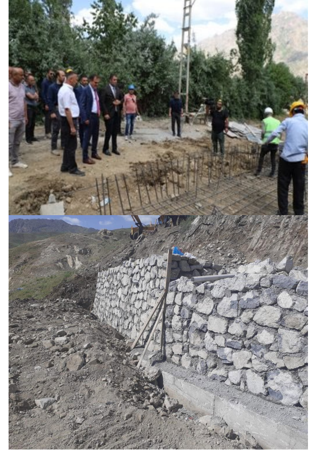
DUVAR YAPIM İŞİ
