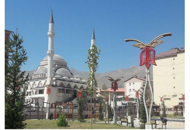
ULU CAMİ YAPIM İŞİ
