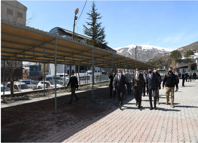
HALK PAZARI YAPIM İŞİ
