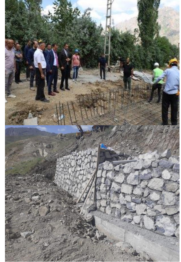
DUVAR YAPIM İŞİ
