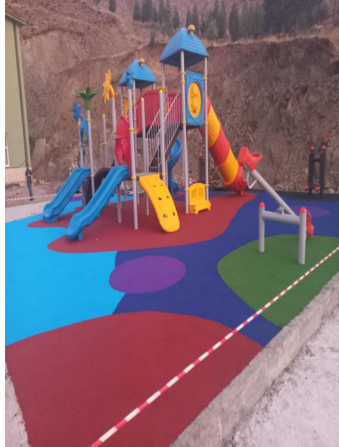
SÜMBÜL MAHALLESİ PARK YAPIM İŞİ
