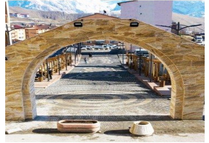
SANAT SOKAĞI YAPIM İŞİ
