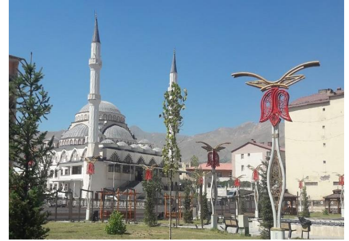
ULU CAMİ YAPIM İŞİ
