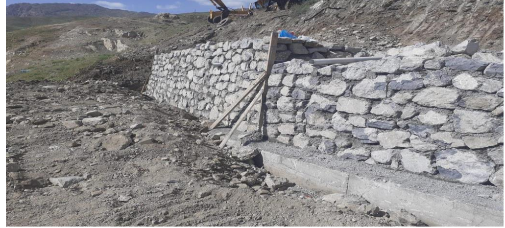
DUVAR YAPIM İŞİ
