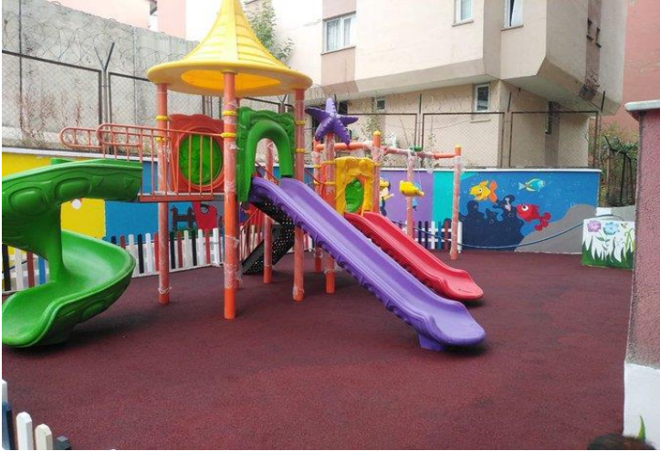
YENİ PARK VE ONARIM İŞİ
