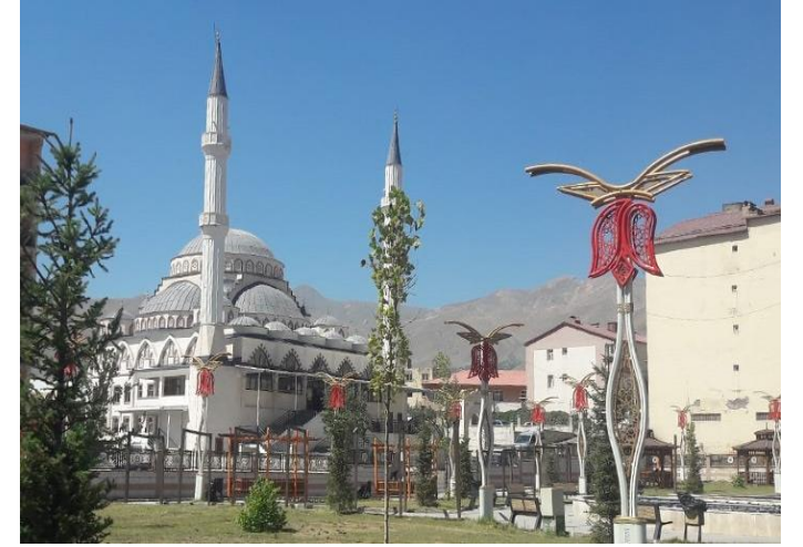
ULU CAMİ YAPIM İŞİ
