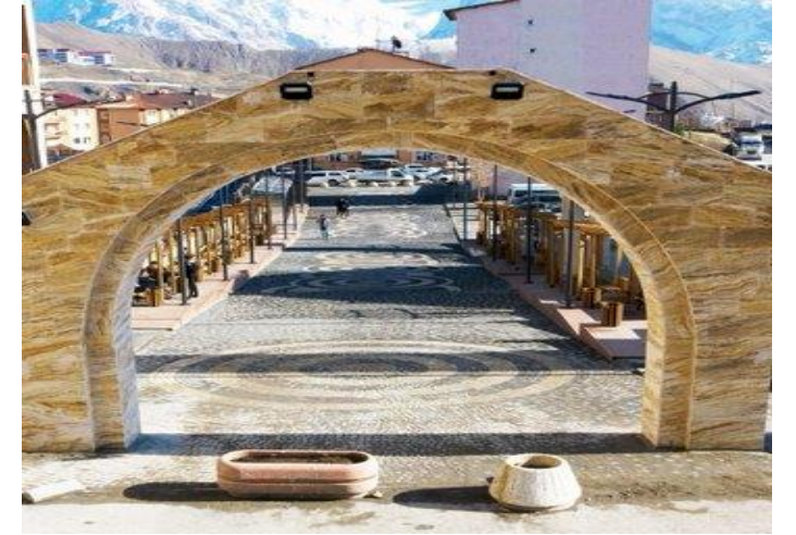
SANAT SOKAĞI YAPIM İŞİ
